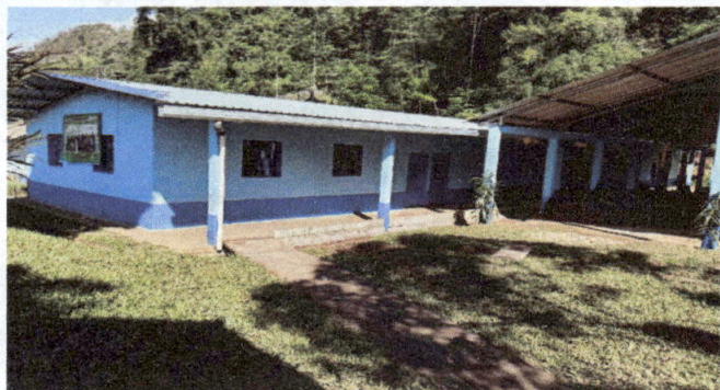
Foto1: Se observa la finalizacion del remozamiento del instituto con el techo colocadas, láminas y canales de agua.
